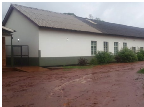
Der alte OP wurde um 8 m erweitert und mit Strahlenschutz umgebaut
