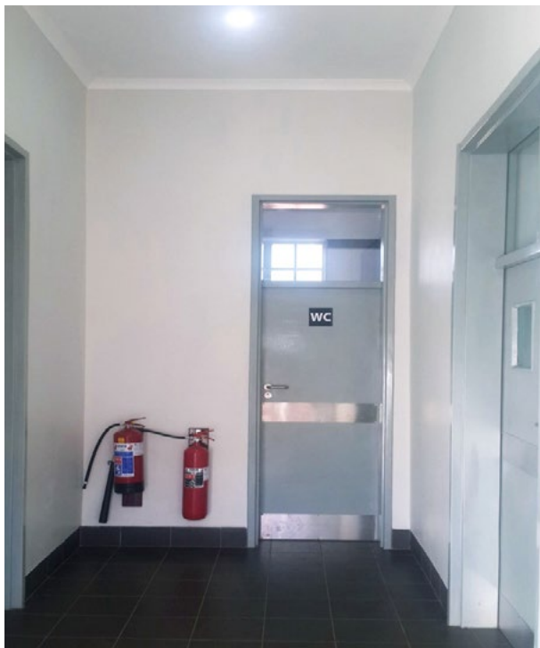
Wartezimmer mit WC, rechts Zugang zu Ultraschall und digitalem Röntgen
